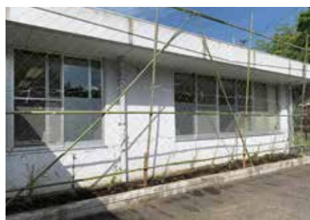
▲グリーンカーテン設置完了
